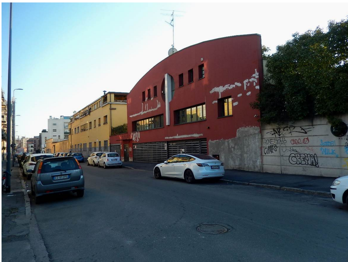
Foto 1 – Vista della facciata sulla via Guintellino.
